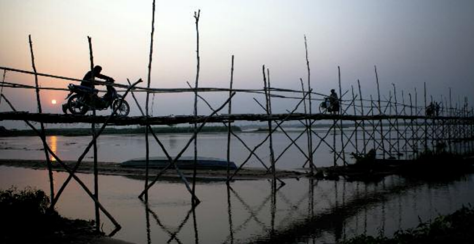
MOTORRÄDER ÜBER ALLES. EINE VERKEHRSACHSE FÜHRT IN DER NÄHE VON BHAMO ÜBER EINE BAMBUSBRÜCKE.
